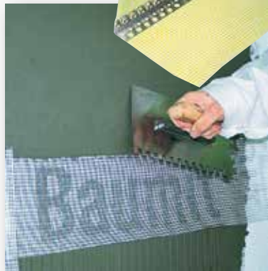
Nakon zaglađivanja ploča Baunit ProContactom za izravnavanje, utisnuti Baunit StarTex (međusobni preklopi su najmanje 10 cm).
