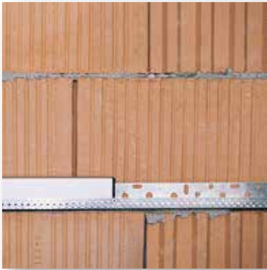
Na području podnožja pričvrstiti SpeedFix lepkom letvicu za podnožje u debljini ploče
